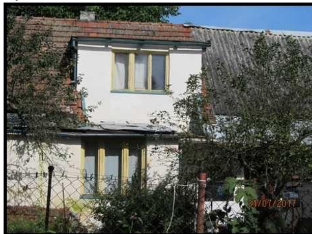
Průčelí RD, vstup
